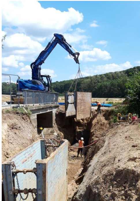
Passage du Soultzbach Travaux Falkwiller 2023
