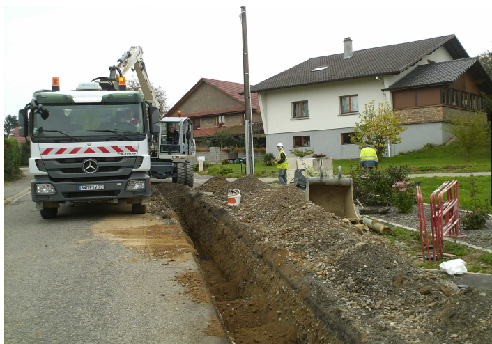
Renouvellement conduite rue principale à Eglingen
