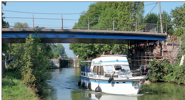
La principale contrainte du chantier était de permettre la poursuite du transport fluvial. Il a donc fallu surélever le pont, et barrer la route aux automobilistes.
