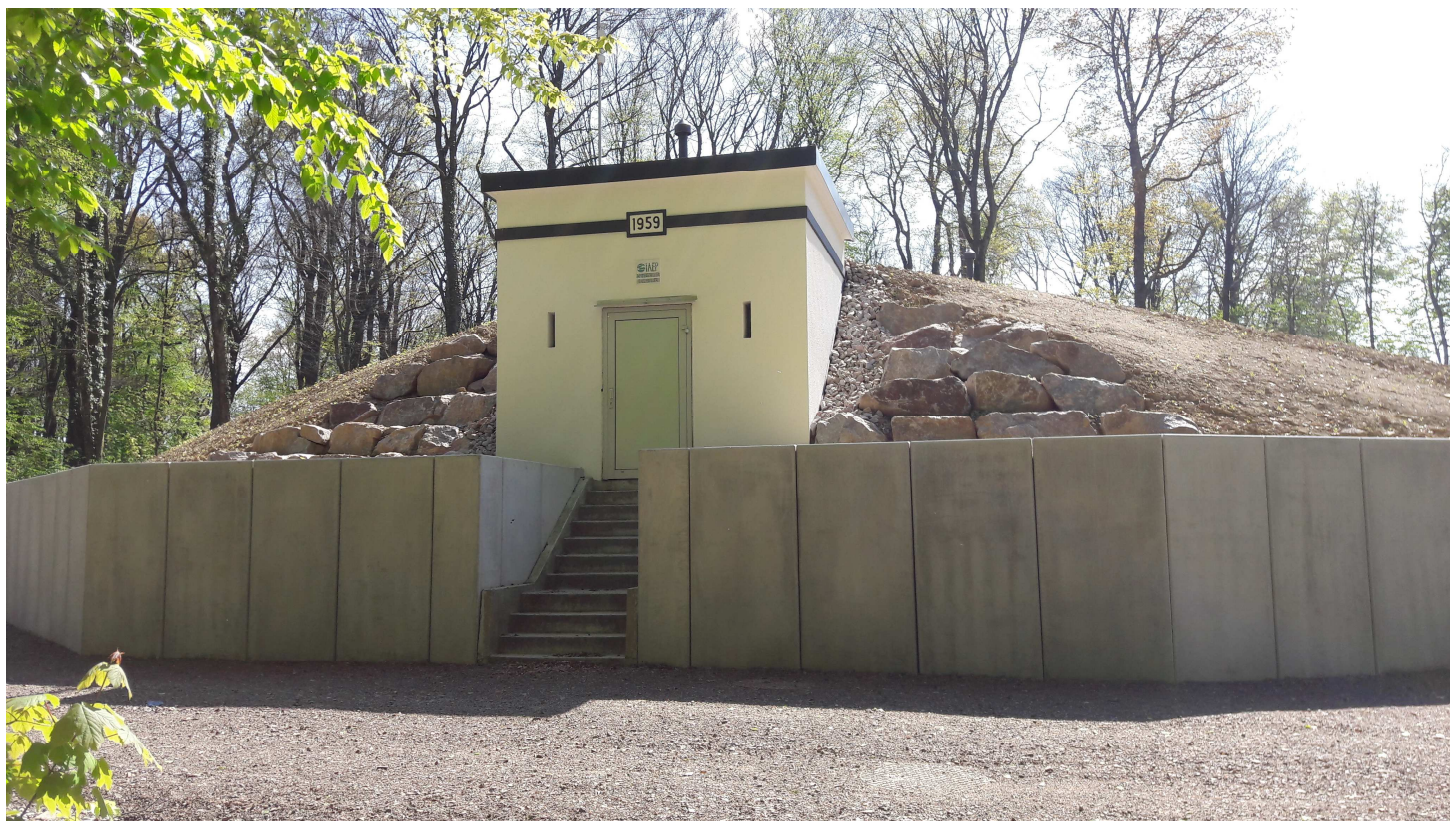
Réservoir de Gildwiller
